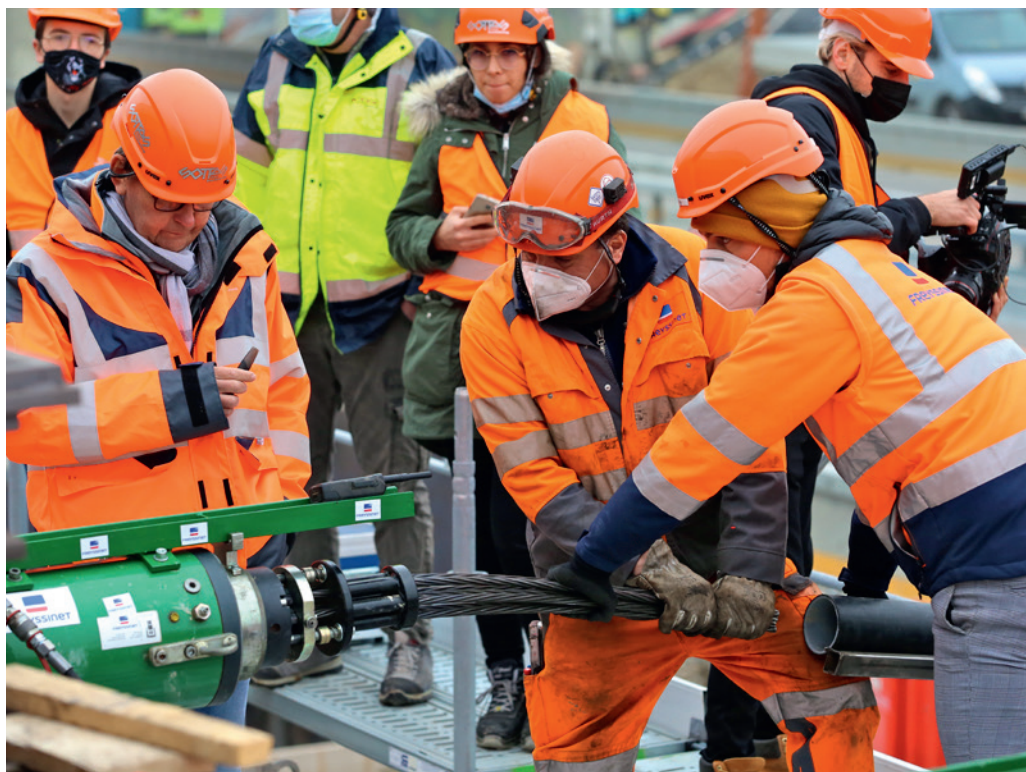
Vérins hydrauliques – système de traction pour le lancement
