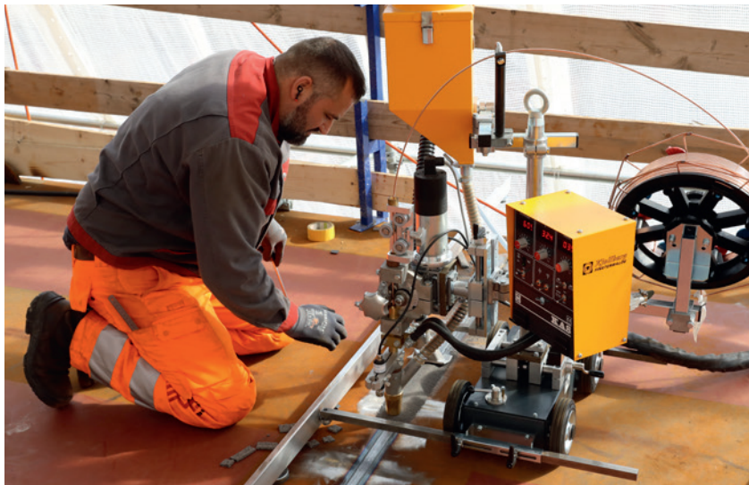
Soudage semi-automatique sous flux au chantier
