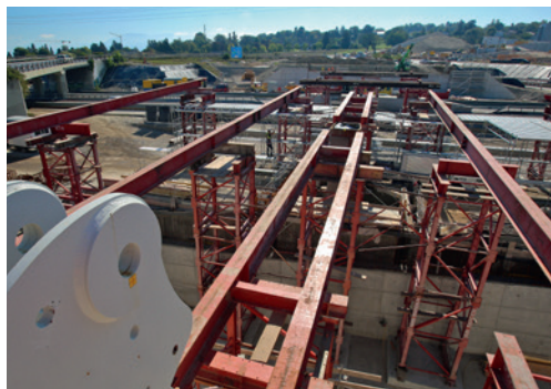
Etayage pour l'assemblage du tablier
