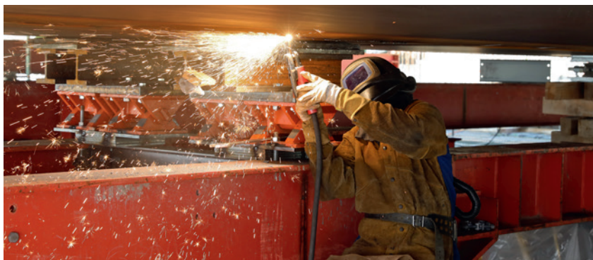
Soudure au chantier
