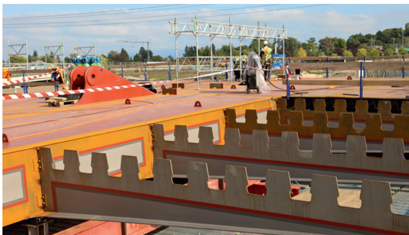
Assemblage du tablier
