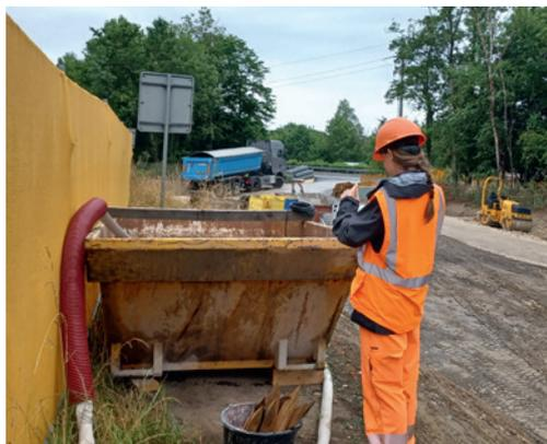
Analyse de la qualité des eaux de chantier (turbidité et pH)
