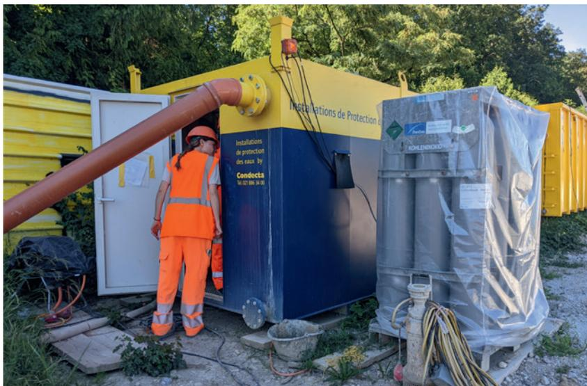
Vérification du bon fonctionnement des installations de traitement des eaux du chantier (décantation et neutralisation)
