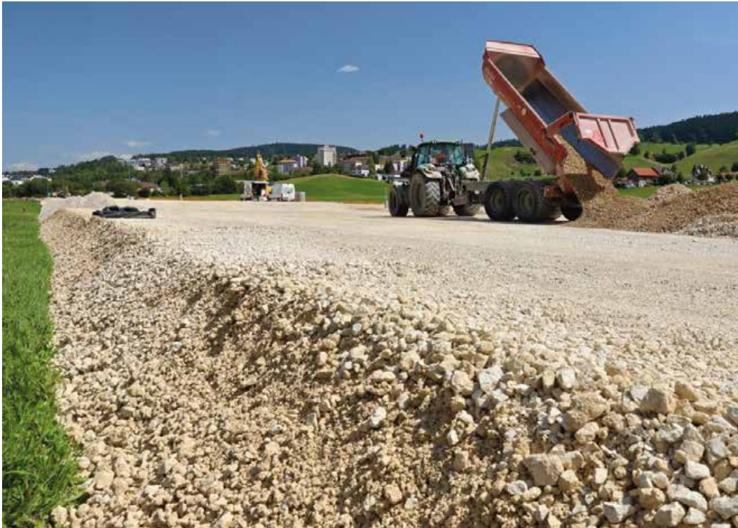
La piste de chantier est réalisée à l'aide des matériaux issus de la gravière.
